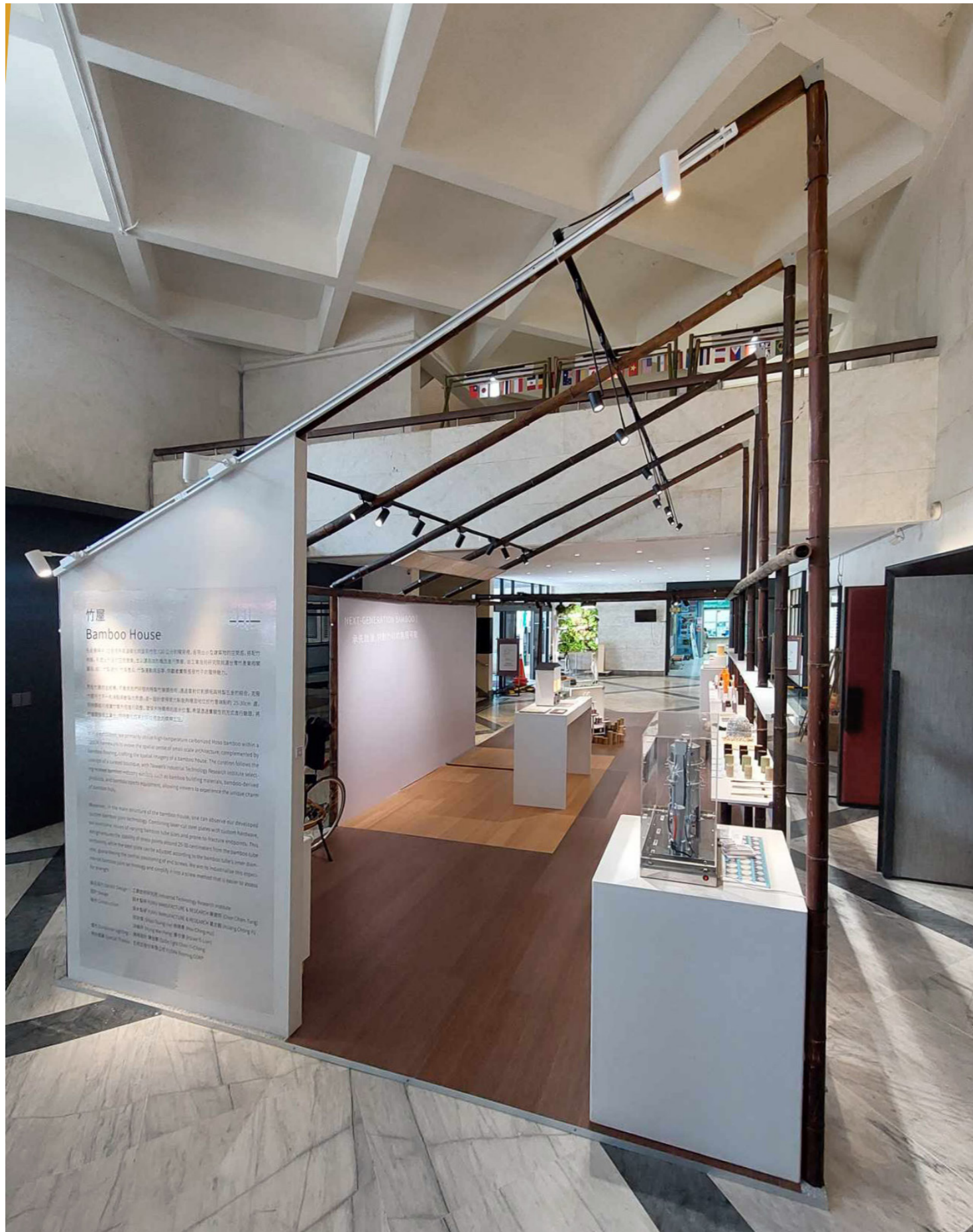
「竹屋」 - 規格化的竹接頭讓展場能在短時間內搭建完成 轉角處搭配鋼板接頭，就可形成通透的空間
